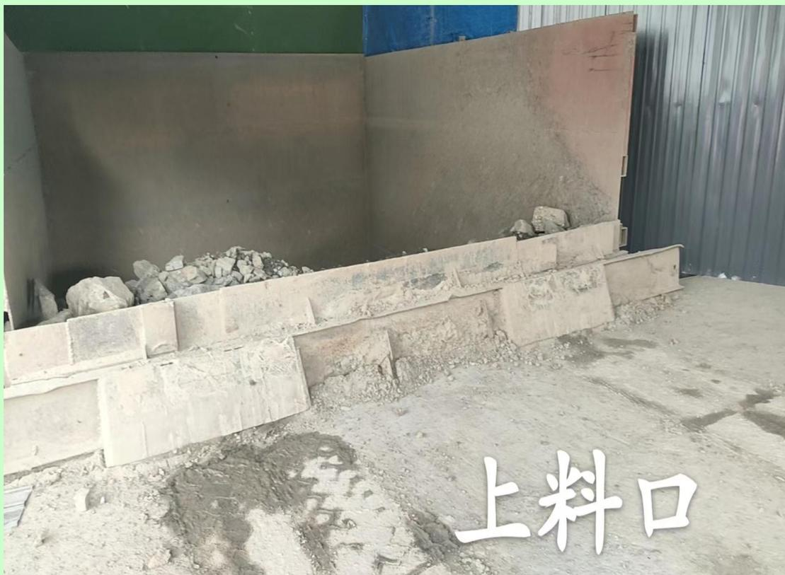
现场照片 9：破碎站卸料口车挡设施
