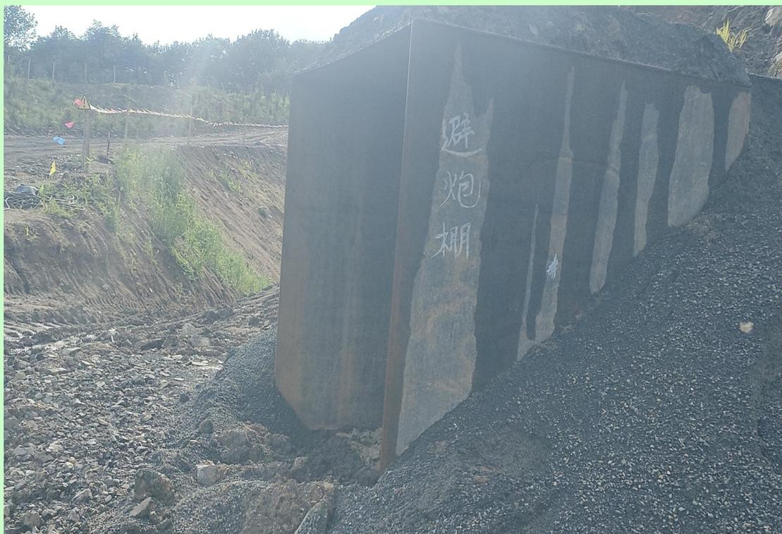
现场照片 1：移动式钢结构避炮棚
