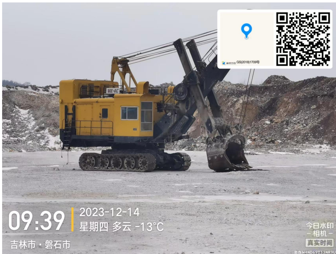
现场照片四：电铲挖掘机
