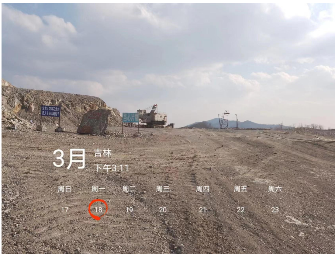
现场照片一：露天采场
